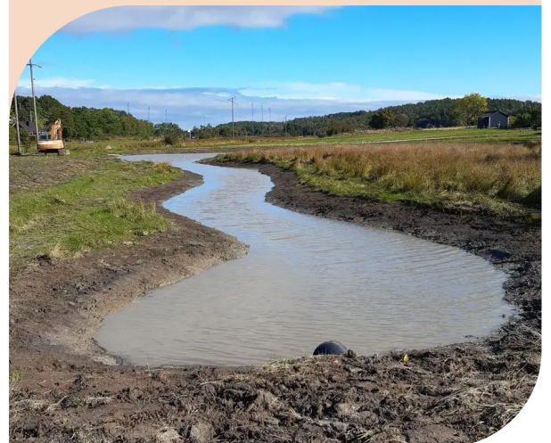
Dammen i Fjällebro under färdigställande hösten 2021.
